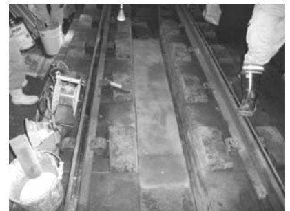
太平洋ゴムラテモルタル トンネル施工写真
