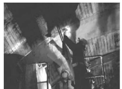
TMネット工法 トンネル施工写真
