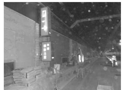
NEXSUS -Super- トンネル施工写真
