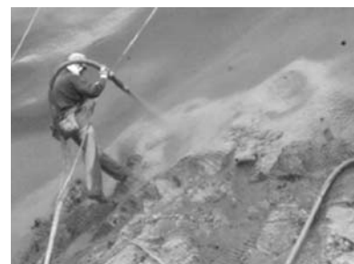
ポーラーセット N-2 添加の法面吹付けコンクリート
